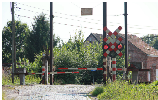
Foto 4: overweg met verkeerslichten.
