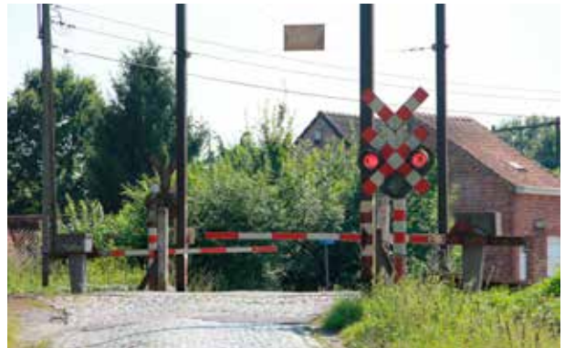
Foto 4: overweg met verkeerslichten.
